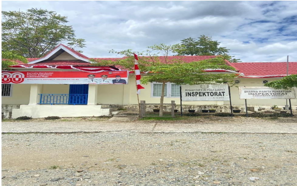
Gambar 2 1 Inspektorat Daerah Kabupaten Kerinci
