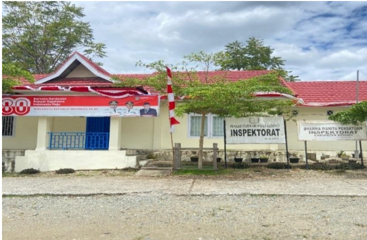
Gambar 2. 1 gedung Inspektorat Daerah Kabupaten kerinci
