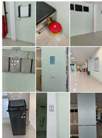
Gambar 5. Dokumentasi sebelum pemasangan label di area IGD dan Instalasi Rawat Jalan
