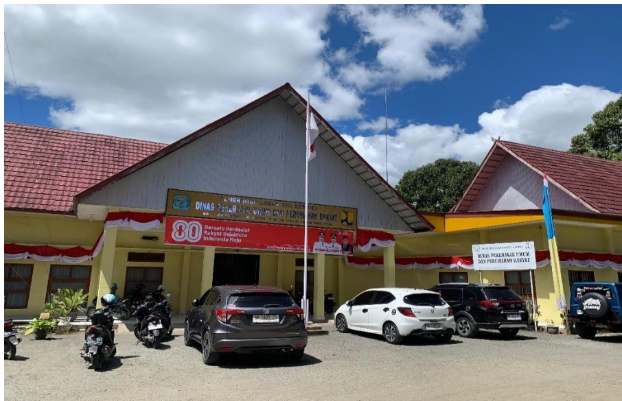
Gambar 1 Kantor Dinas Pekerjaan Umum dan Perumahan Rakyat (PUPR) Kabupaten Kerinci
