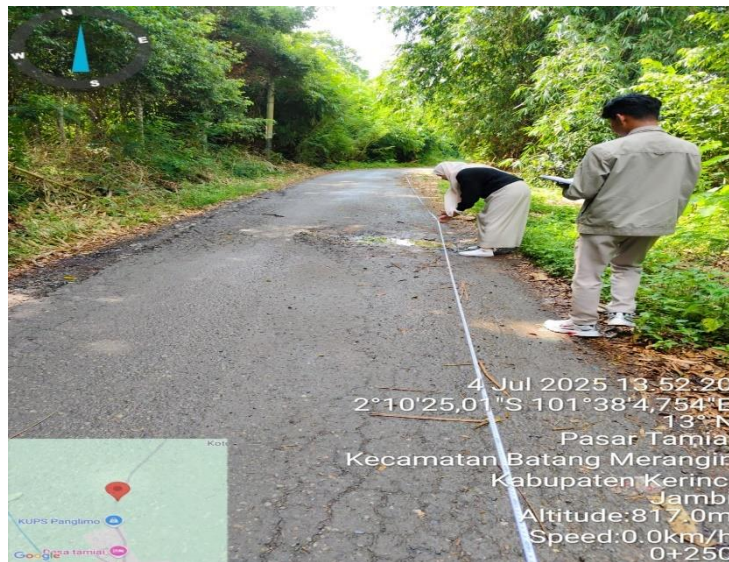
Gambar 3 Survey Kondisi Jalan Secara Manual
