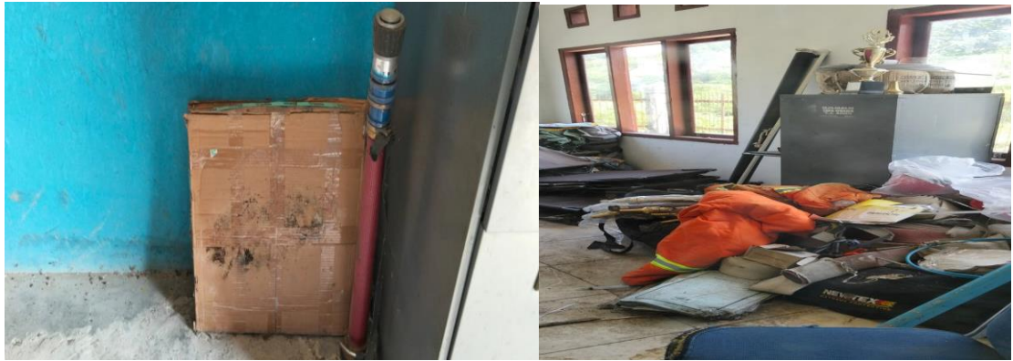
Gambar 3.3 Peralatan Pemadam Kebakaran
