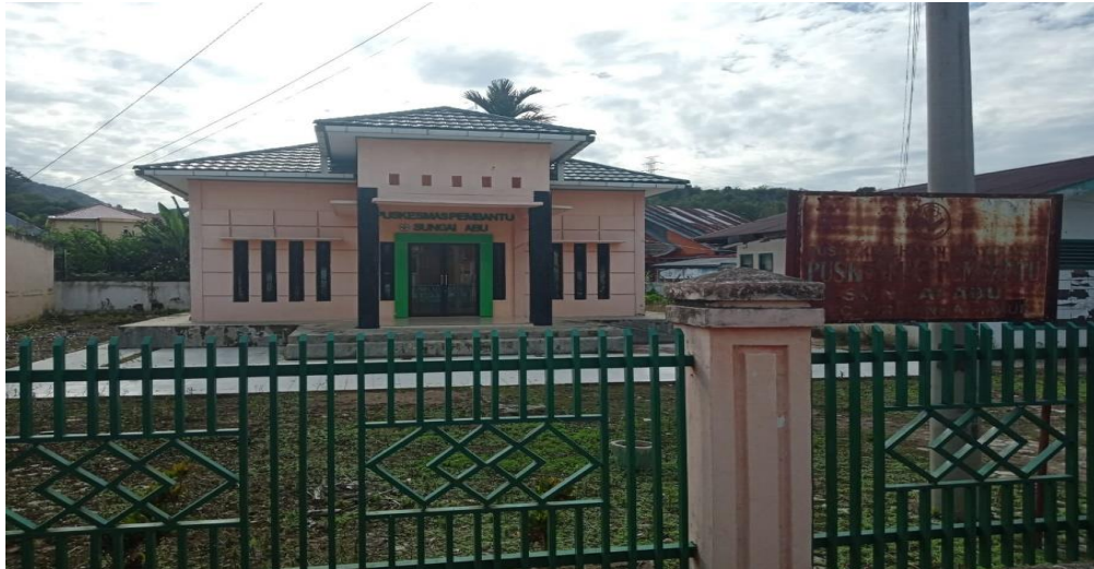
Gambar 5. Foto lokasi yang dipilih untuk pemasangan PAPI KEREN
