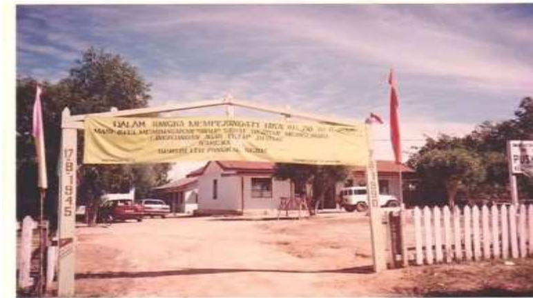
Gambar 2.1: Kondisi Puskesmas Bukit Kapur pada Tahun 1990
