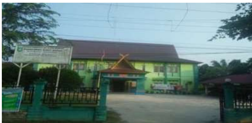
Gambar 2.2: Kondisi Puskesmas Bukit Kapur pada Tahun 2018
