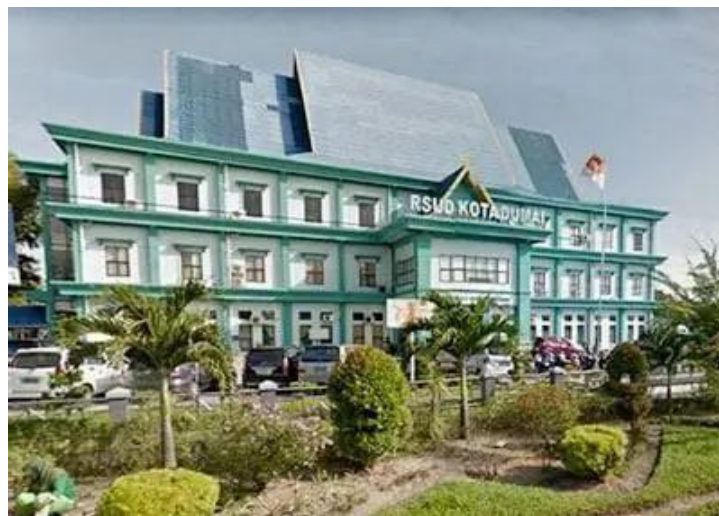
Gambar 2. 1 Bangunan Rumah Sakit Umum Daerah Kota Dumai
