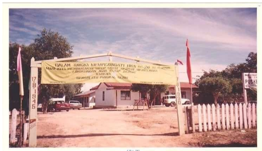
Gambar 2.1 Kondisi Puskesmas Bukit Kapur pada Tahun 1990
