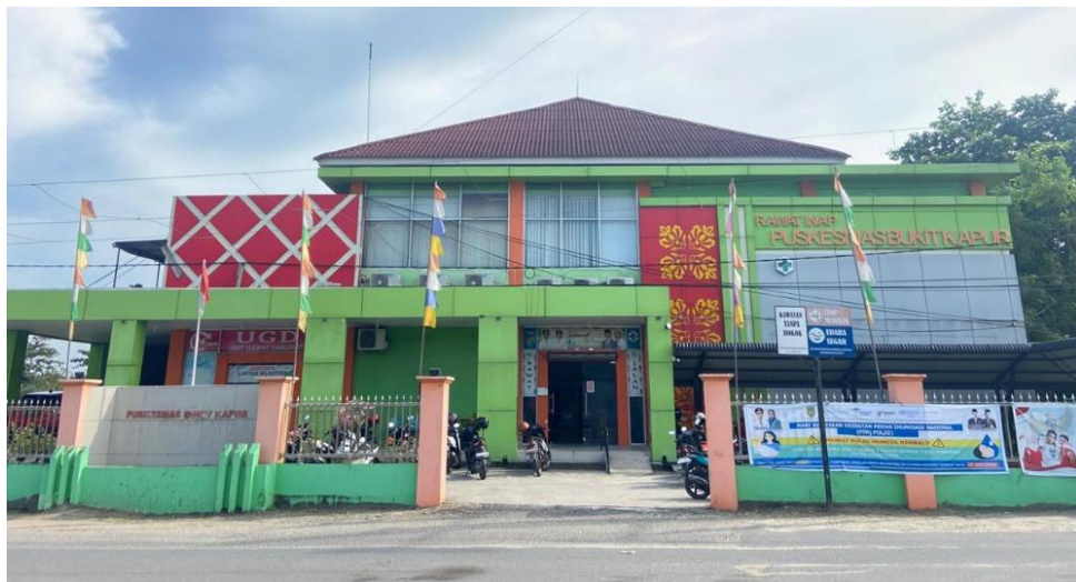
Gambar 2.3 Kondisi Puskesmas Bukit Kapur pada Tahun 2025
