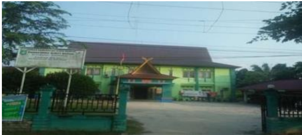
Gambar 2.2 Kondisi Puskesmas Bukit Kapur pada Tahun 2018
