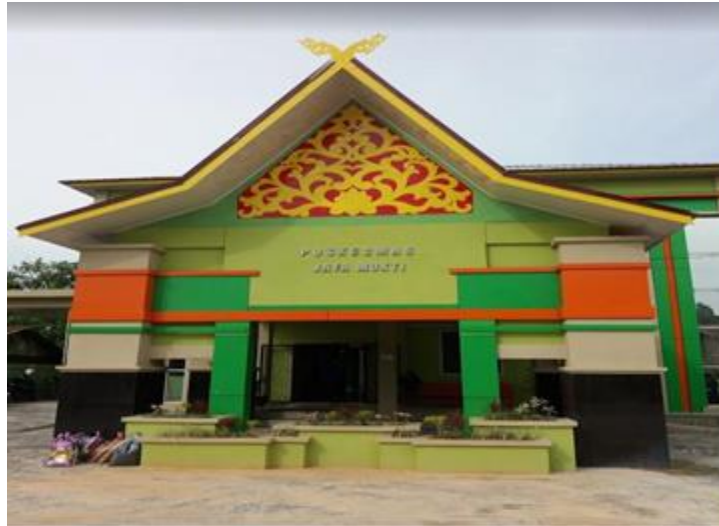
Gambar 2.1. Gedung Puskesmas Jaya Mukti
