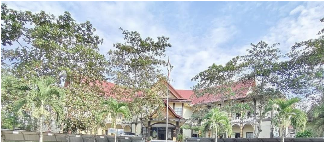
Gambar 2. 1 Gedung BAPPEDA Kota Dumai
