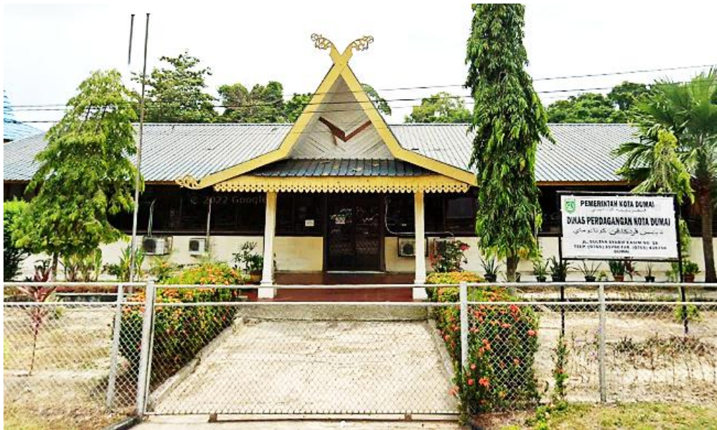
Gambar 1. Bangunan Dinas Perdagangan Kota Dumai
