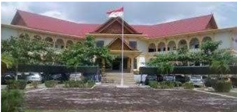
Gambar 1. Kantor Badan Perencanaan Pembangunan Daerah Kota Dumai
