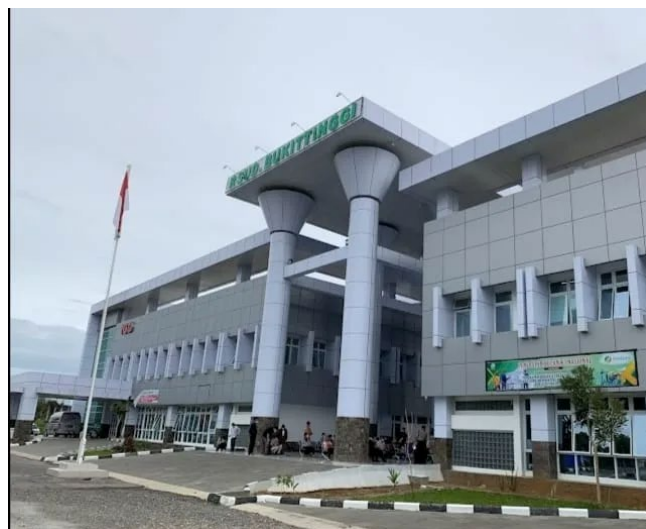
Gambar 1. Gedung RSUD Kota Bukittinggi
