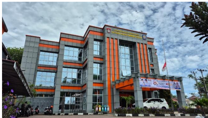
Gambar 2. 1 Kantor Satpol PP Kota Bukittinggi
