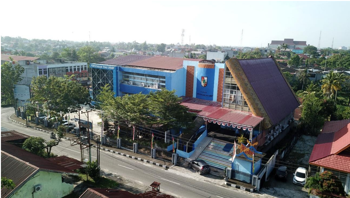
Gambar 2.1 Gedung Dinas Perpustakaan dan Kearsipan Kota Pekanbaru
