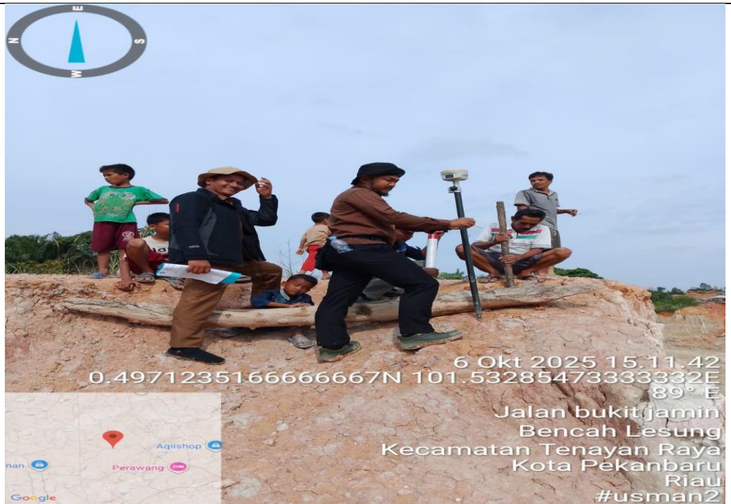
Gambar 29: Pengukuran bidang tanah pserta Konsolidasi Tanah
