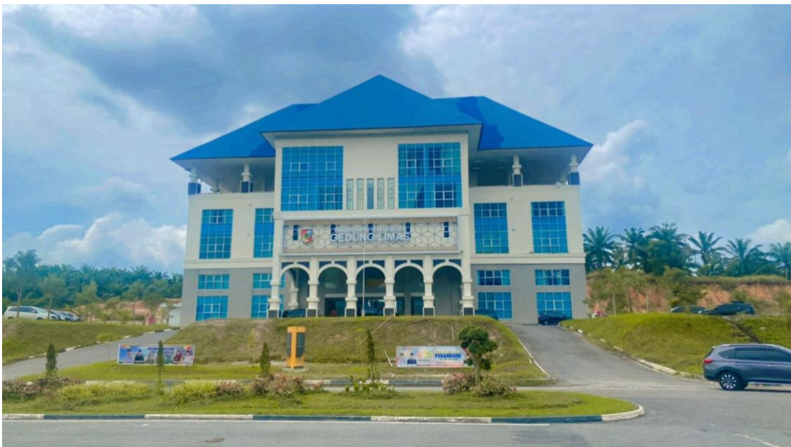
Gambar 2. 1 Gedung B5 Kompleks Perkantoran Tenayan Raya
