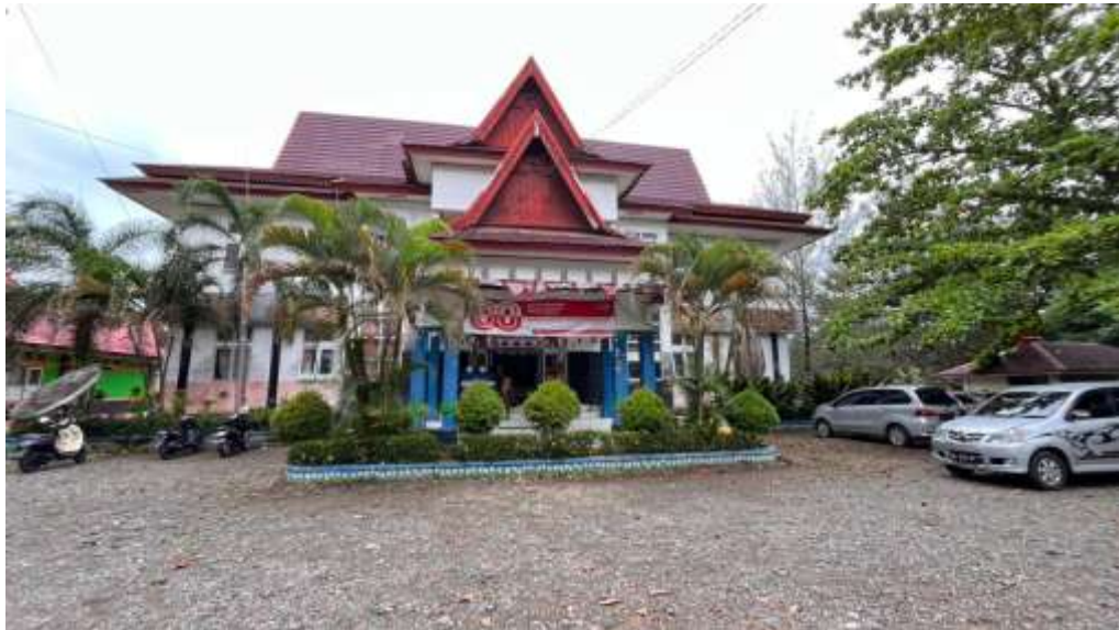
Gambar 2.1. Bangunan Dinas Pendidikan dan Kebudayaan Kabupaten Mukomuko
