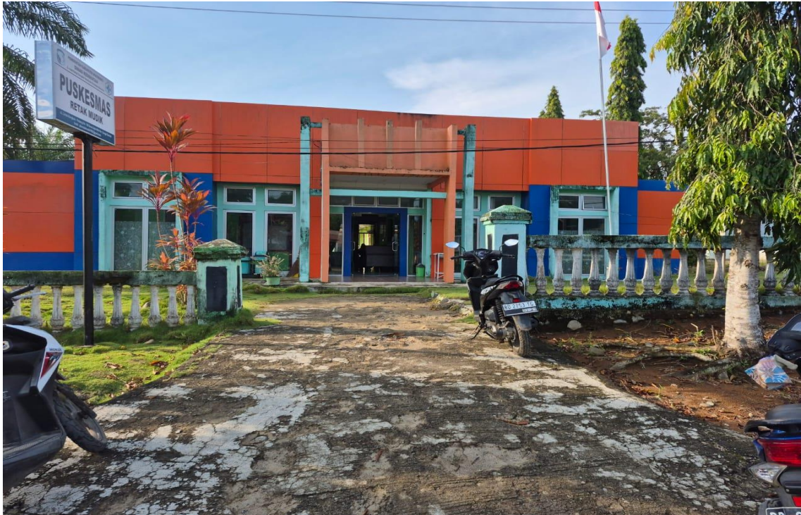
Gambar 2.1 Bangunan UPTD Puskesmas Retak Mudik
