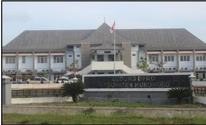
Gambar 2.1 Gedung DPRD Kabupaten Mukomuko
