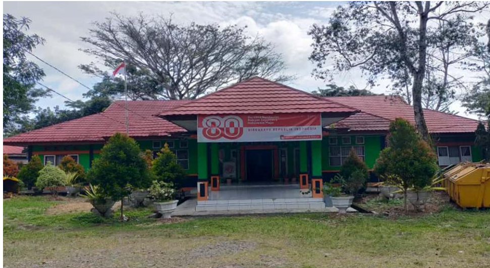
Gambar 2.1. Bangunan Dinas Lingkungan Hidup Kabupaten Mukomuko
