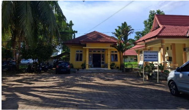
Gambar 2.1 Kantor Dinas Tenaga Kerja dan Transmigrasi Kabupaten Mukomuko
