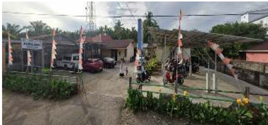
Gambar 2.1 Bangunan UPTD Puskesmas Lubuk Sanai
