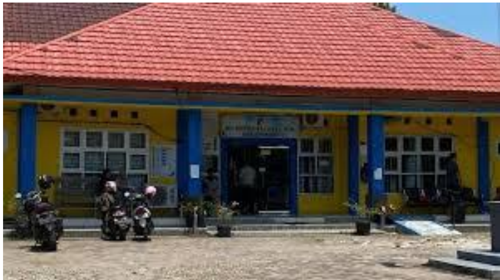
Gambar 2.1 Bangunan Dinas Dukcapil Kabupaten Mukomuko
