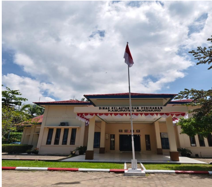
Gambar 1. Bangunan Dinas Perikanan Kabupaten Mukomuko
