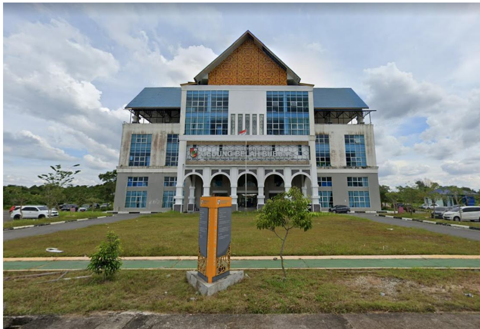
Gambar 2.1 Bangunan Gedung Belah Bubung Dp3apm Kota Pekanbaru 2025
