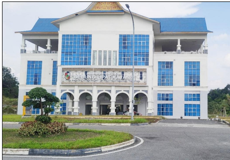
Gambar 2. 1 Dinas Pekerjaan Umum dan Penataan Ruang Kota Pekanbaru
