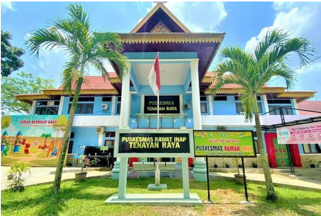
Gambar 2.1. Bangunan Puskesmas Tenayan Raya
