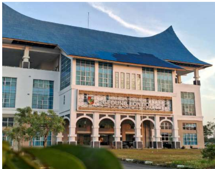
Gambar II-1 Gedung Lontio Lt. 4-5 BPP Kota Pekanbaru
