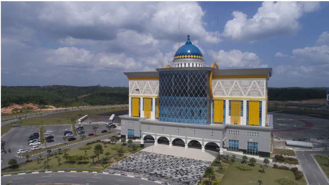
Gambar 2.1. Gedung Dinas P3APM Kota Pekanbaru
