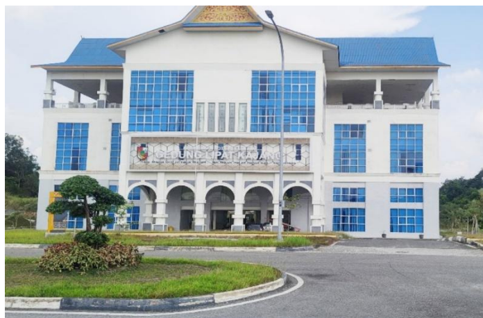
Gambar 2.1. Dinas Pekerjaan Umum dan Penataan Ruang Kota Pekanbaru
