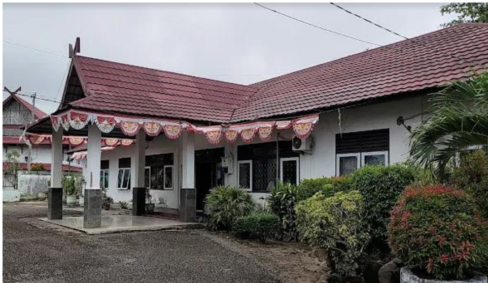
Gambar 2.1. Bangunan Dinas Tanaman Pangan, Hortikultura, dan Perkebunan
