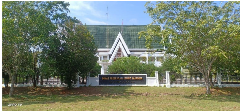
Gambar 2.1 Kantor Dinas Pekerjaan Umum, Tata Ruang, Perumahan Rakyat, dan Kawasan Pemukiman Kab.Siak
