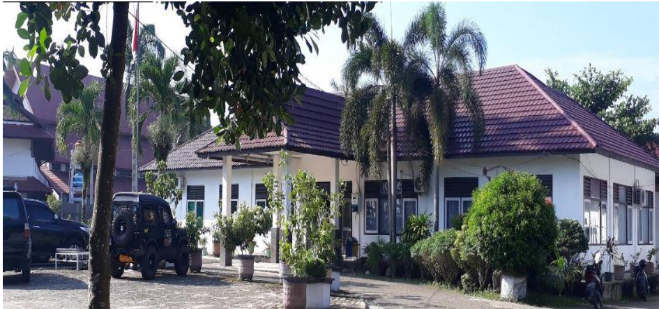
Gambar 2.1 Bangunan Dinas Tanaman Pangan, Hortikultura, dan Perkebunan Kabupaten Bungo
