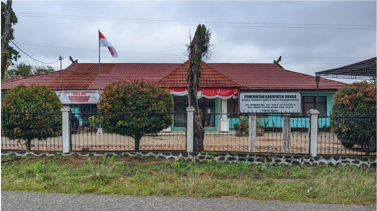
Gambar 2. 1 Kantor Dinas Tenaga Kerja dan Transmigrasi Kab. Bungo
