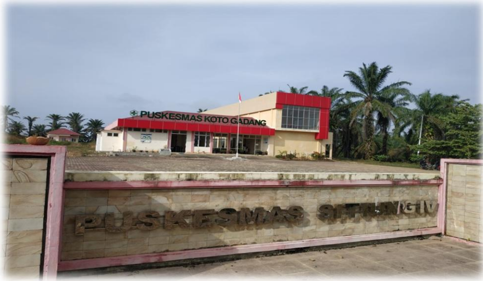
Gambar 2.1 Gedung UPT Puskesmas Sitiung IV
