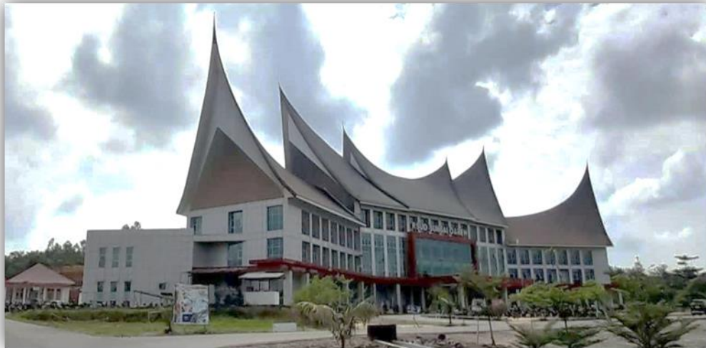
Gambar 1. Gedung Utama UPTD RSUD Sungai Dareh
