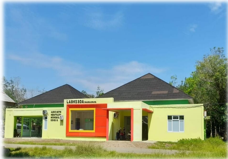
Gambar 2.1 Gedung UPTD Labkesda Kabupaten Dharmasraya
