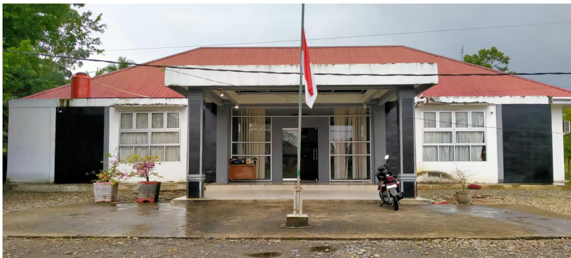
Gambar 2.1 Kantor Inspektorat Daerah Kabupaten Dharmasraya
