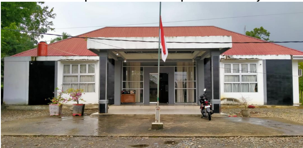
Gambar 2. 1 Kantor Inspektorat Daerah Kabupaten Dharmasraya
