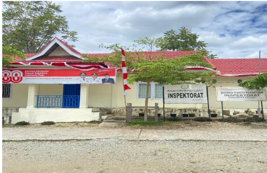
Gambar 2.1 Gedung Inspektorat Daerah Kabupaten Kerinci
