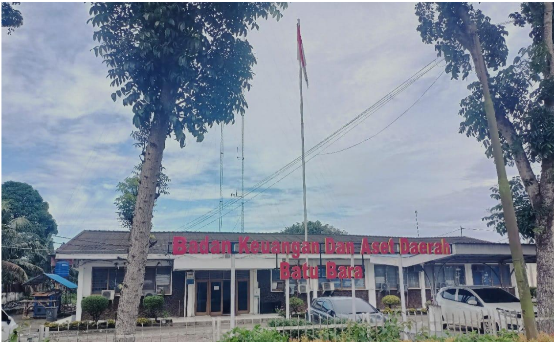
Gambar 2.1 Gedung Kantor BKAD Kabupaten Batu Bara
