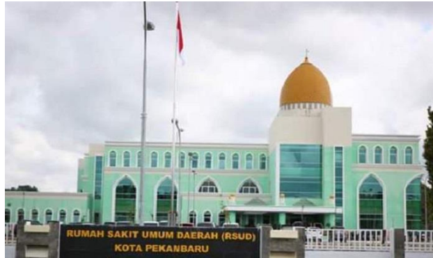
Gambar 2.1 Gedung RSD Madani Kota Pekanbaru
