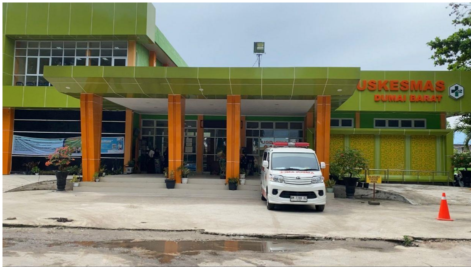
Gambar 2.1 Gambar Bangunan Puskesmas Dumai Barat
