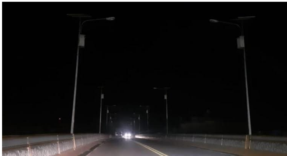
Gambar III. 2 LPJU mati di Fly Over Bukittinggi
